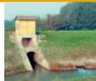
Siel, Durchlassbauwerk im Schutzdamm und Hochwasser-Pumpwerk am Rußbach
